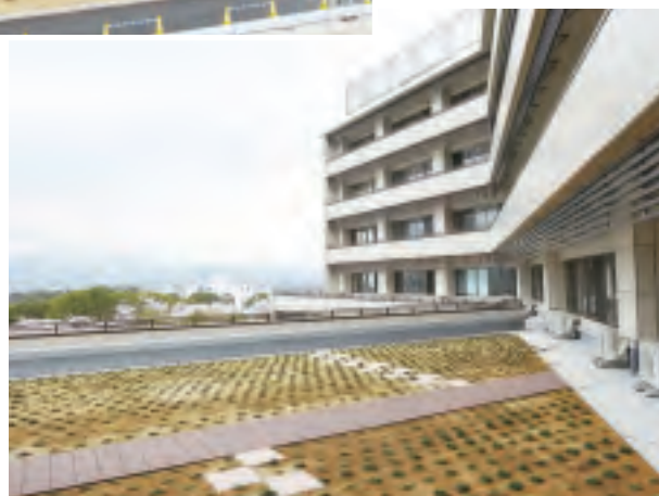
▼セダムが植えられた3階屋上
