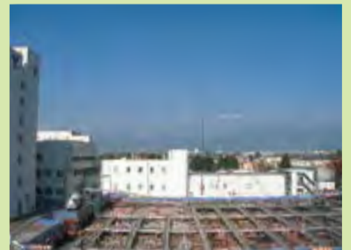
新病棟建設工事の状況 (平成25年11月18日現在)
