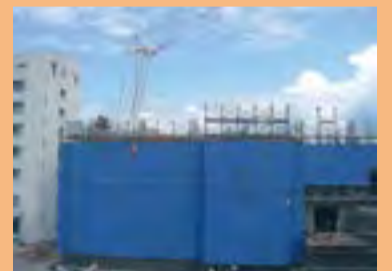
新病棟建設工事の状況(平成26年6月9日現在)
