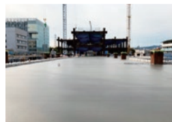
2階床コンクリート
