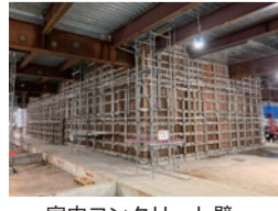
室内コンクリート壁
