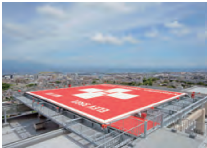
ヘリポート(屋上)
