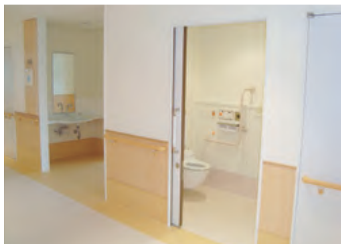
4床室用トイレ
