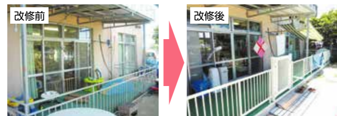
床面の沈みや柵の腐食が目立った既存設備から新設した(面積も増床)。また、門扉を設置して各保育室から園庭への出入りを容易にした。
